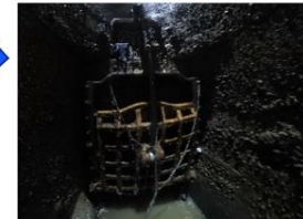
Sewer Door Penstock
